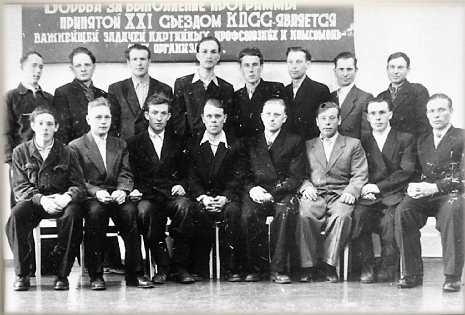
Бригада коммунистического труда треста «Апатитстрой». 1960 г. ГОКУ ГАМО в г. Кировске. Ф. Р-42. Оп. 6. Д. 398.
