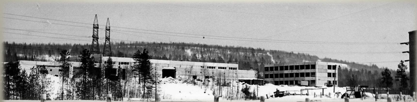
Строительство молокозавода в г. Апатиты. 1982 г ГОКУ ГАМО в г. Кировске. Ф. Р-520. Оп. 1. Д. 3363.
