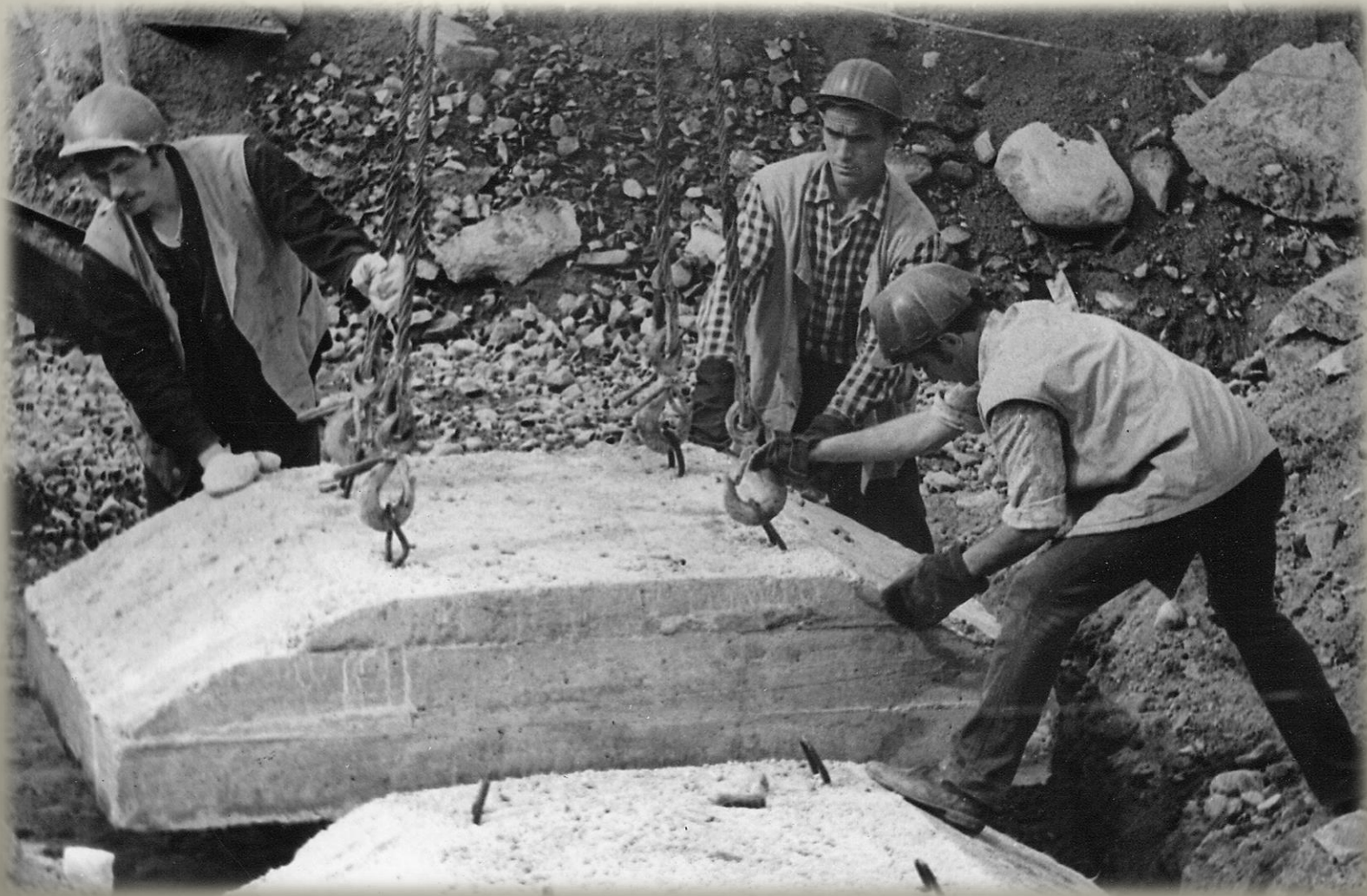
Монтажники Кировского СМУ треста «Апатитстрой». 1975 г. ГОКУ ГАМО в г. Кировске. Ф. Р-520. Оп. 1. Д. 2261.
