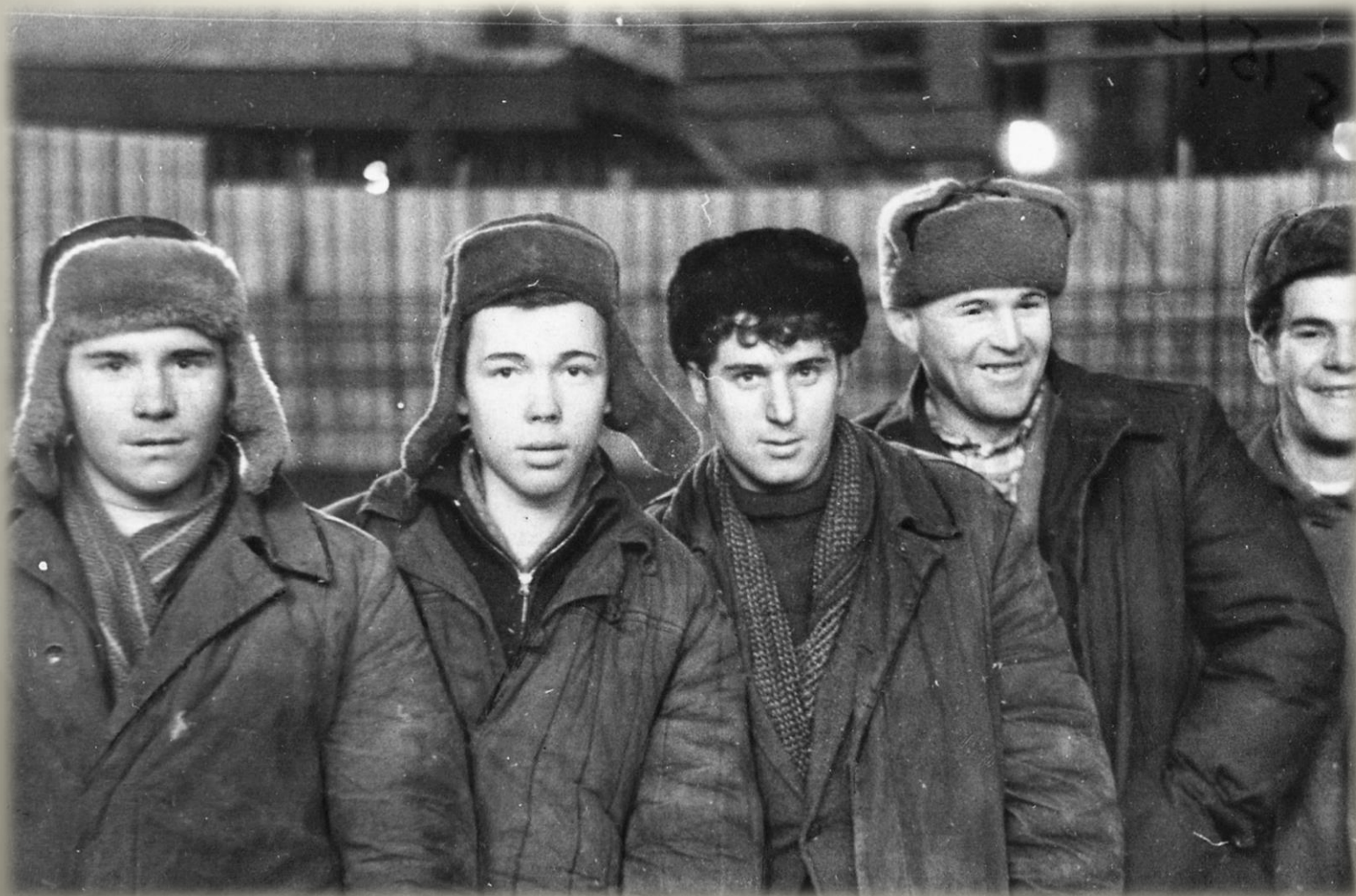
Члены бригады В.Шадрина на строительстве АНОФ-2. 1964 г. К. Александров. ГОКУ ГАМО в г. Кировске. Ф. Р-19. Оп. 3. Д. 373.
