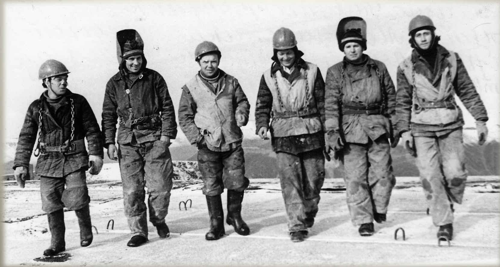
Монтажники передовой бригады СМУ «Рудстрой» треста «Апатитстрой» под руководством Петрова ведут работы на Плато Расвумчорр. 1976 г. ГОКУ ГАМО в г. Кировске. Ф. Р-520. Оп. 1. Д. 2474.
