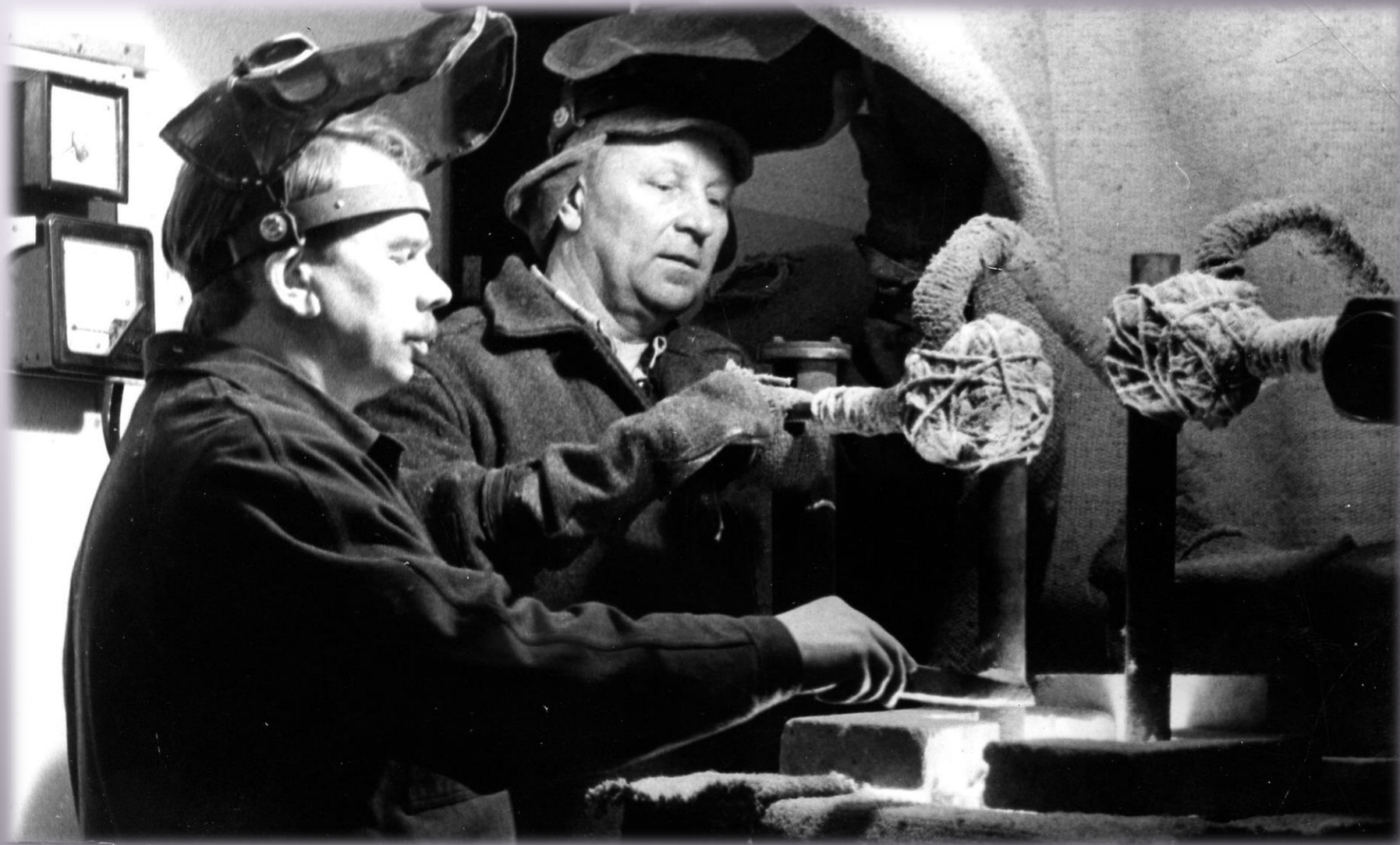
Кандидат технических наук М.Е. Кононов и старший лаборант Г.П. Бурдо Кольского филиала АН СССР работают над получением высокоогнеупорных плавяных материалов на основе бадделеитового концентрата. г. Апатиты. 1982 г. ГОКУ ГАМО в г. Кировске. Ф. Р-520. Оп. 1. Д. 3512.
