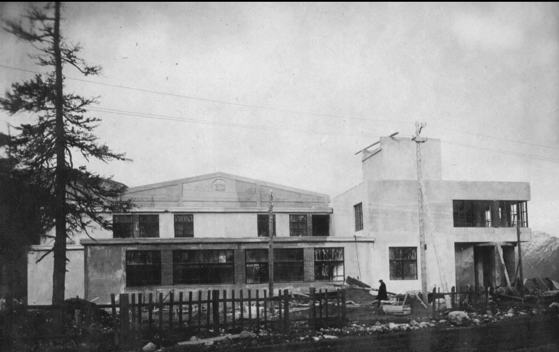
Строительство кинотеатра «Большевик». 1932 г.
