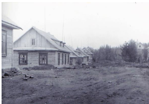
Строится поселок Молодежный
