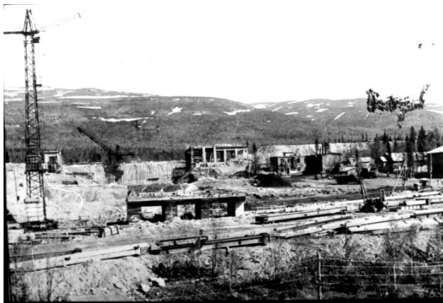
Панорама строительства АНОФ-2. 1962 г.
