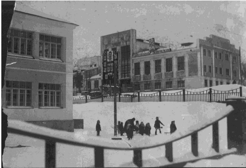
Оформление клуба горняков к первым выборам в Верховный Совет СССР, 12 декабря 1937 года
